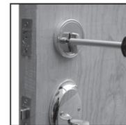
B. Deslice la mariposa por la parte interior completamente y apriete los tornillos.
